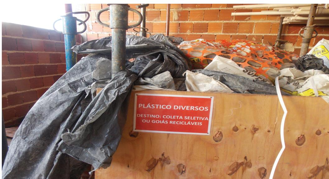
Figura 28: Separação de entulhos formados por plásticos.
