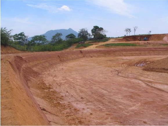
Figura 7 – Preparação da área para impermeabilização.
