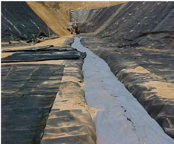
Figura 9 – Sistema de drenagem de chorume e de gás.
