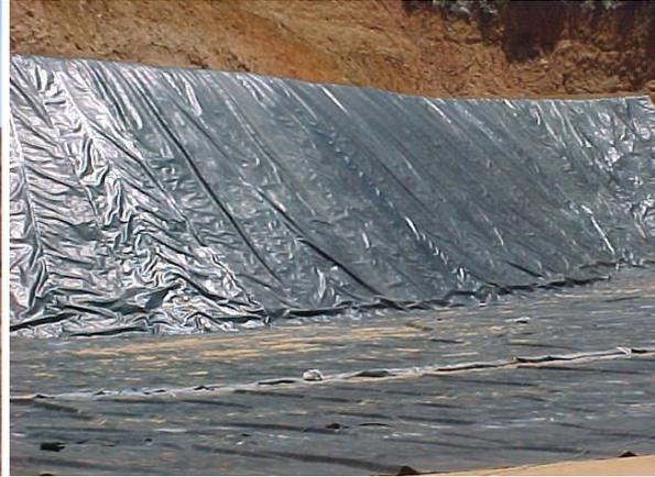
Figura 8 – Impermeabilização do solo com manta.
