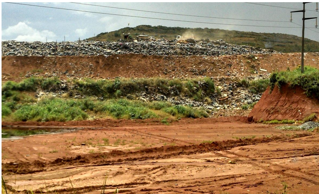
Figura 5 – Aterro Sanitário de Goiânia. Fonte: Arquivo - Comurg – GO.
