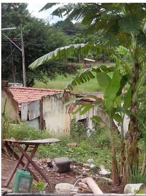
Figura 16 – Vila Coronel Cosme – ocupação irregular e moradias precárias Fonte: Pesquisa, (2012)
