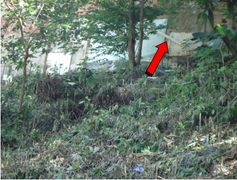
Figura 13 – Lançamento de esgoto doméstico Fonte: Pesquisa, (2012)
