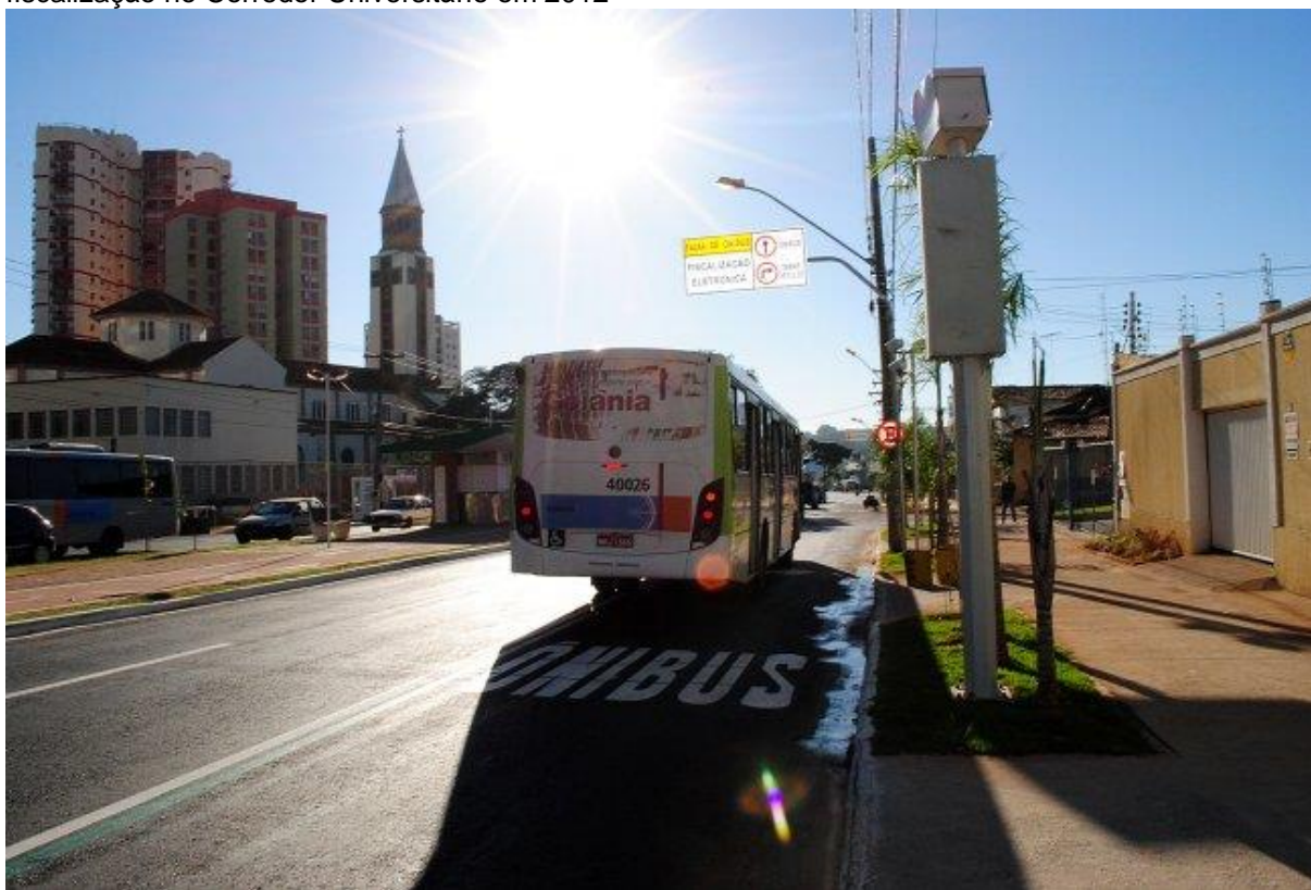
FIGURA 39 - Faixa exclusiva com sinalização horizontal, vertical, sistema de monitoramento e fiscalização no Corredor Universitário em 2012
