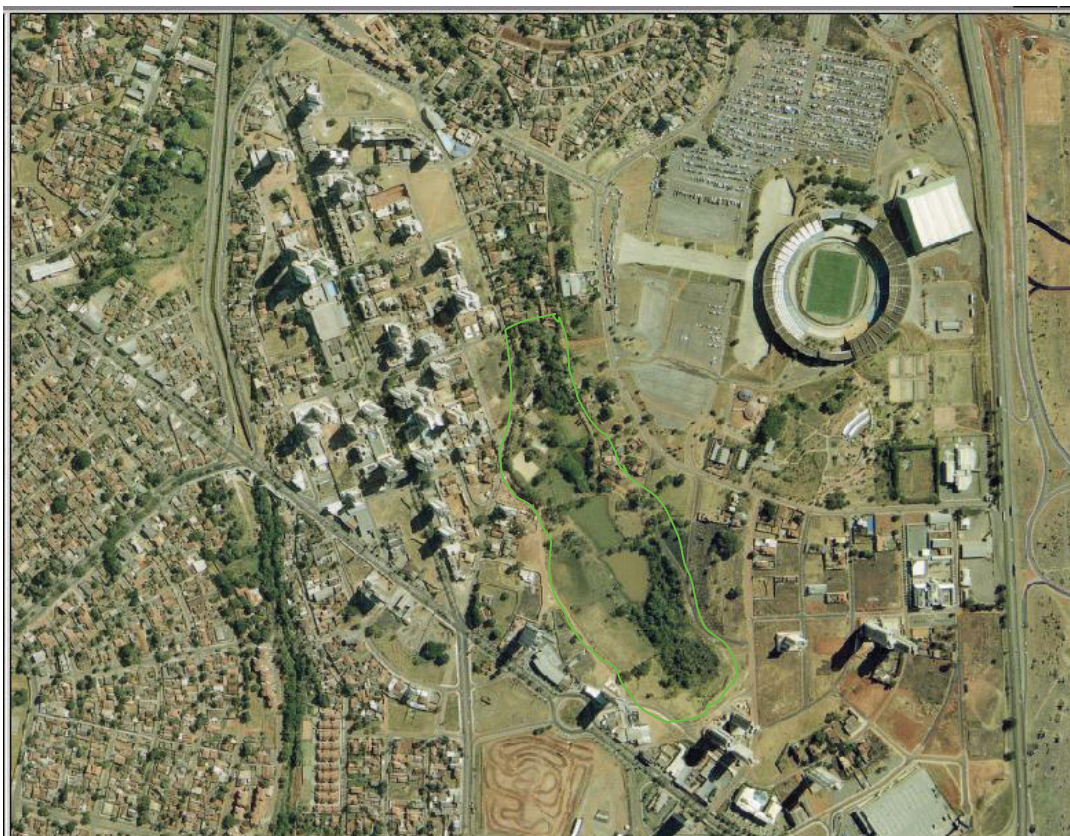
Figura 26 - Imagem Aérea do Parque Flamboyant – 2002. Fonte: Arquivo SEPLAM. — Área do Parque Flamboyant.
