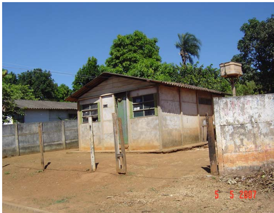
Figura 2. Casa padrão da Vila Mutirão, construída em 1983.
