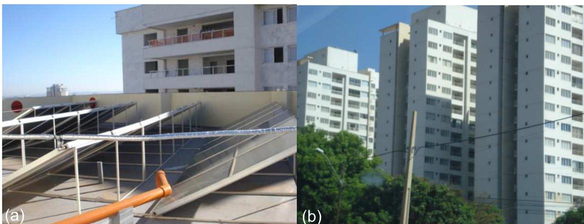
Figura 8 – Sombreamento; (a) sombreamento das placas solares pelo edifício construído ao lado do visitado; (b) sombreamento do edifício proporcionado pelo edifício do próprio condomínio Foto: Paula, G. M.
