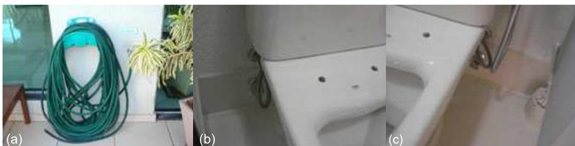
**Figura 3 -** Reuso da água da chuva, (a) torneira e mangueira para irrigação e lavagem dos pisos da área comum; (b) registro da água para uso do vaso sanitário - lado esquerdo para água de reuso da chuva; (c) registro da água para uso do vaso sanitário - lado direito para água limpa da concessionária. Fotos: Paula, G. M.
