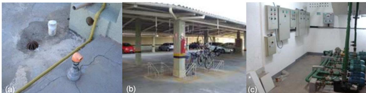
**Figura 2-** Uso da água da chuva: (a) ralo para coleta da água de chuva na laje; (b) cobertura para captação da água da chuva e calhas para condução da água captada; (c) conjunto de bombas e quadros para o acionamento do sistema de água da chuva. Foto: Paula, G. M.
