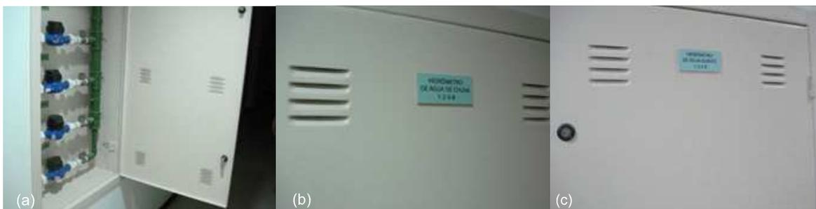
Figura 7 – Medidores de consumo; (a) medidor de água potável; (b) caixa do medidor da água da chuva; (c) caixa do medidor da água quente. Fotos: Paula, G. M.
