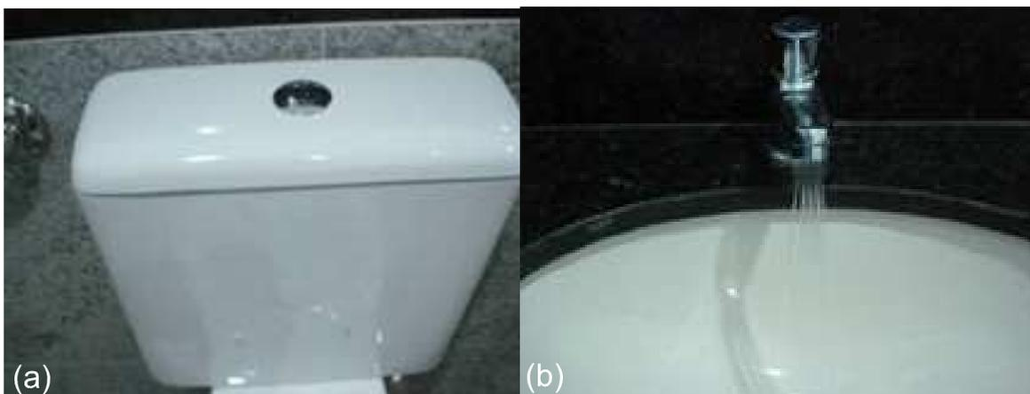
Figura 6 – Economizadores de água; (a) caixa acoplada da bacia sanitária de 6L e acionamento duplo; (b) torneira com acionamento automatizado e arejador. Fotos: Paula, G. M.
