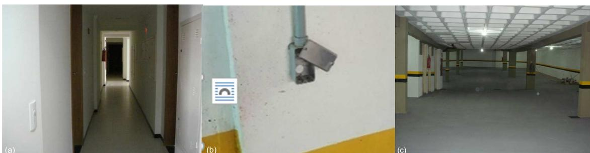
Figura 11 – Equipamentos economizadores de energia; (a) sensor de presença na altura do usuário; (b) tomadas para carros elétricos; (c) garagem pintadas para otimizar a iluminação. Foto: Paula, G. M.
