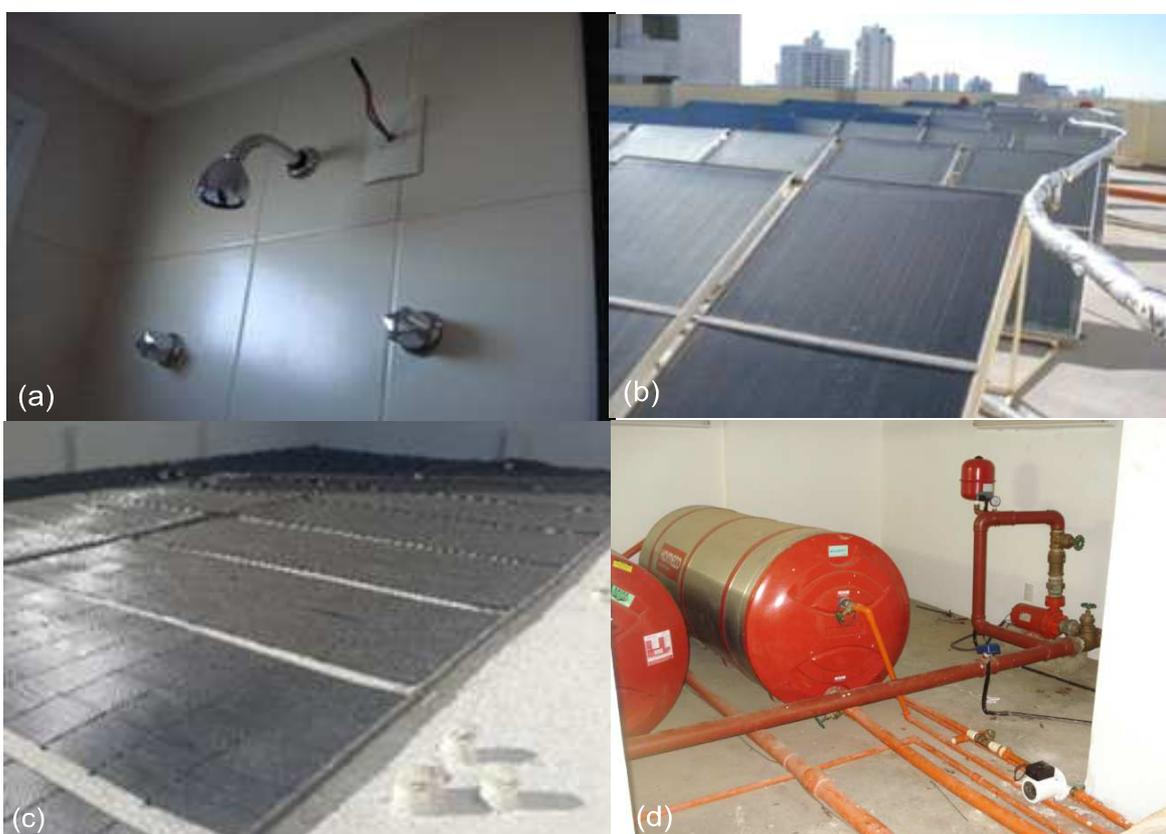
Figura 13 – Equipamentos economizadores de energia; (a) chuveiro para água quente com possibilidade de instalar o elétrico; (b) placas de aquecimento solar da água com vidro e serpentina; (c) serpentina de aquecimento solar da água; (d) boilers para armazenamento da água quente. Foto: Paula, G. M.
