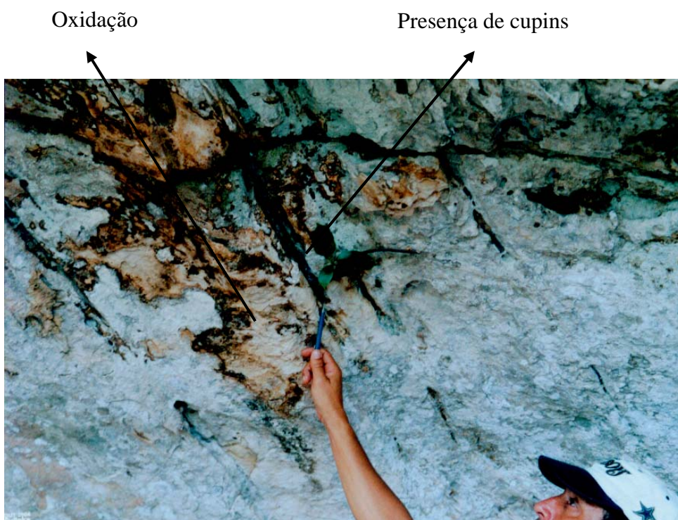
FIGURA 6.16 – GO-JA-04 (Gruta do Paredão). Detalhe da ação conjunta de intemperismo químico (oxidação) e biológico (cupins).
