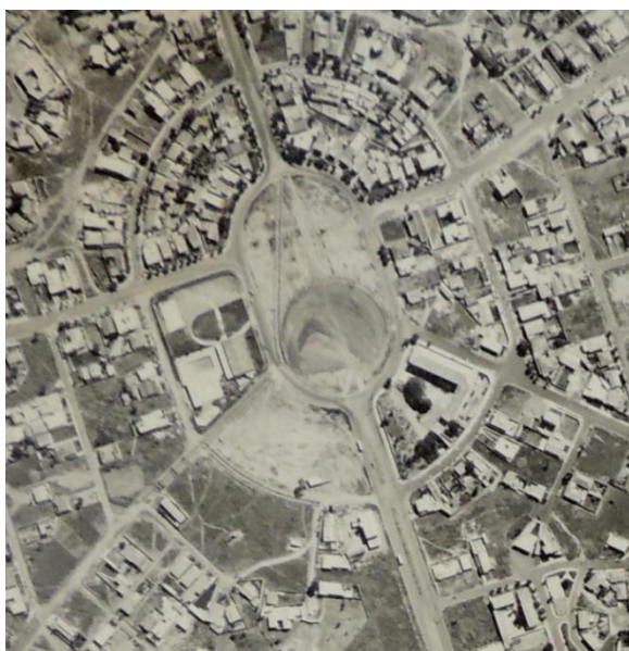
Figura 23: A Praça do Cruzeiro sendo construída
