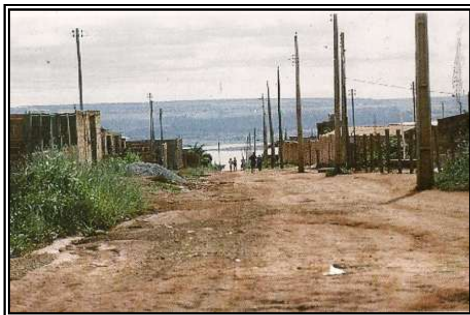
Foto: Secretaria Municipal de Obras
