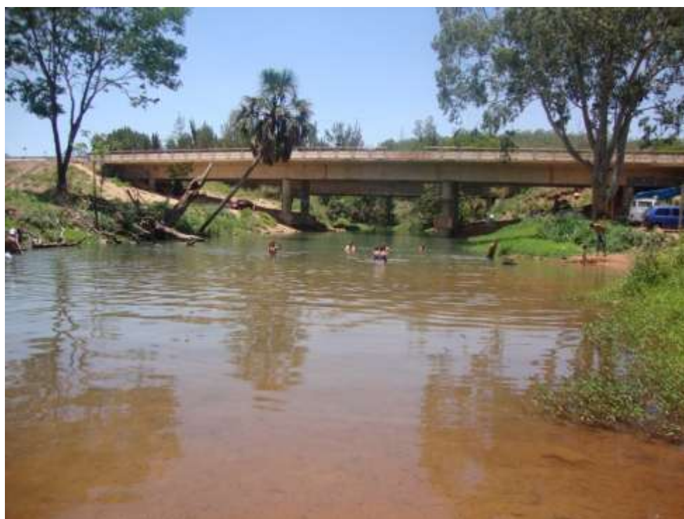
Figura 25: Barragem do Rio Descoberto (Outubro-2012)
