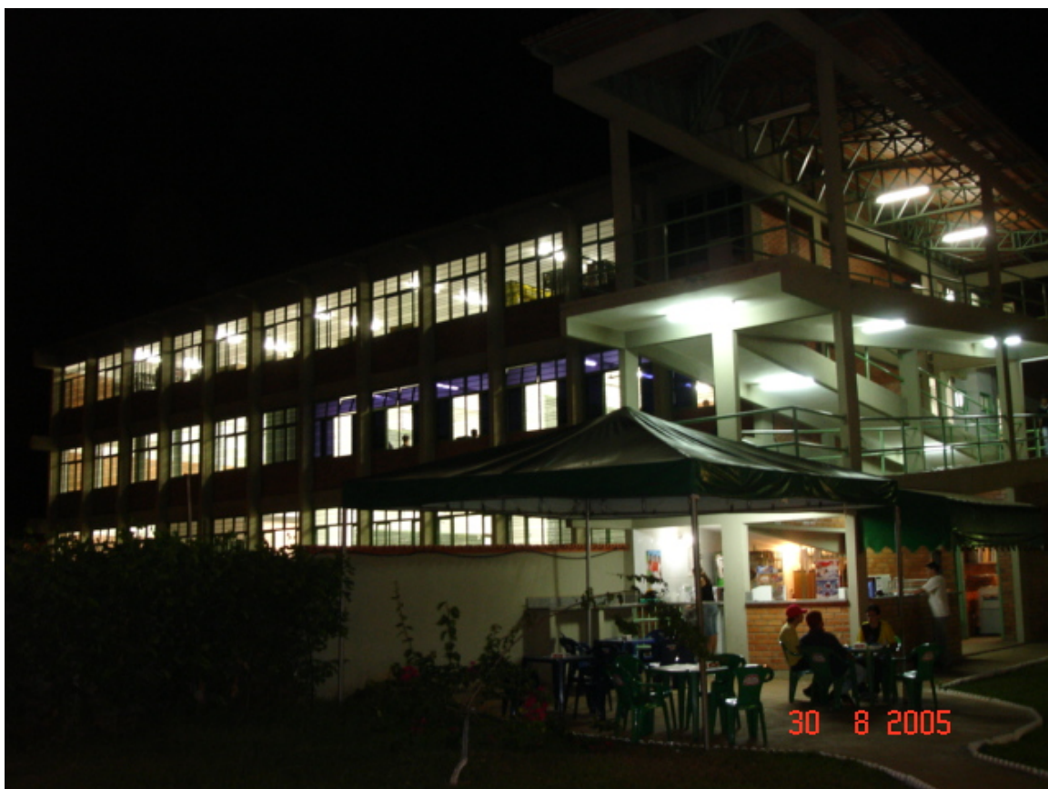
Foto 6 - Instalações atuais da FACER – Vista interna - 2005
