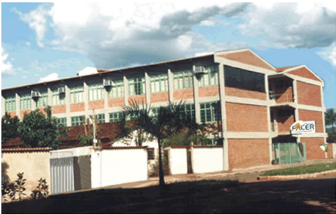
Foto 4 - Instalações atuais da FACER - 2004
