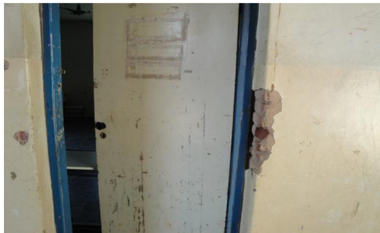
Figura 3 - Estrutura física da escola – Porta da sala de aula
