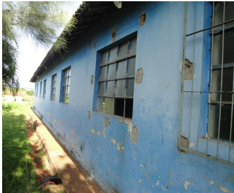
Figura 2 - Estrutura física da escola - janelas
