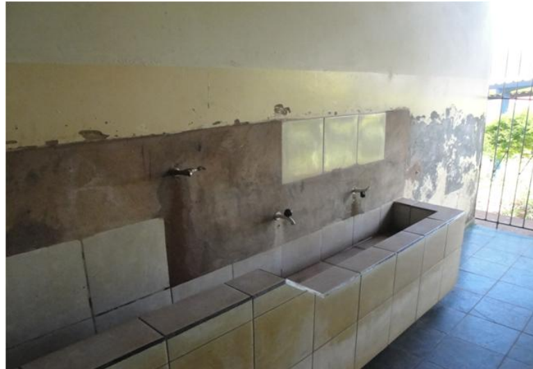
Figura 1 - Estrutura física da escola - bebedouro
