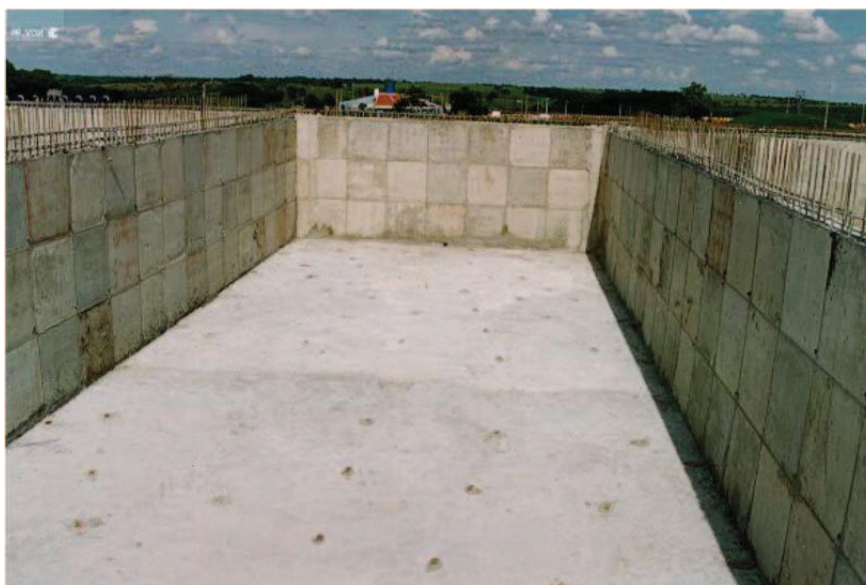
Figura. 10 Construção do Depósito Fonte: Site do CRCN-CO 38
