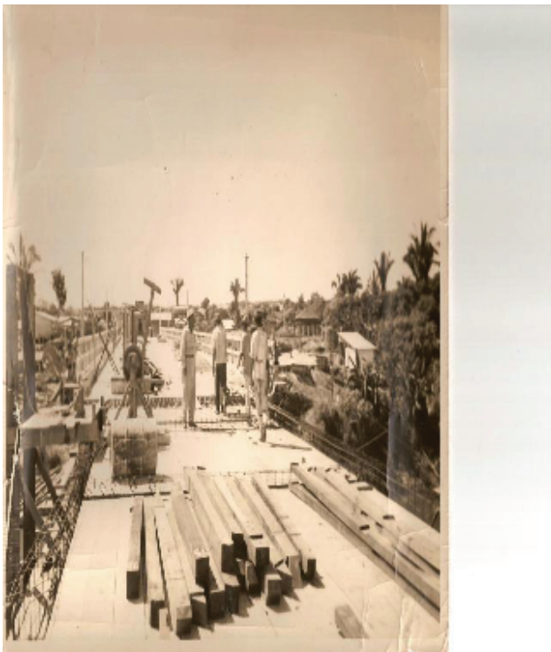
Ilustração: Obras da ponte sobre o Rio Araguaia.
