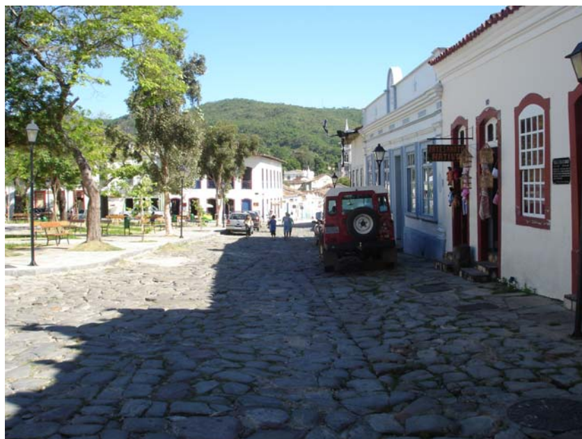
Fachadas características das construções do centro histórico da cidade de Goiás.
