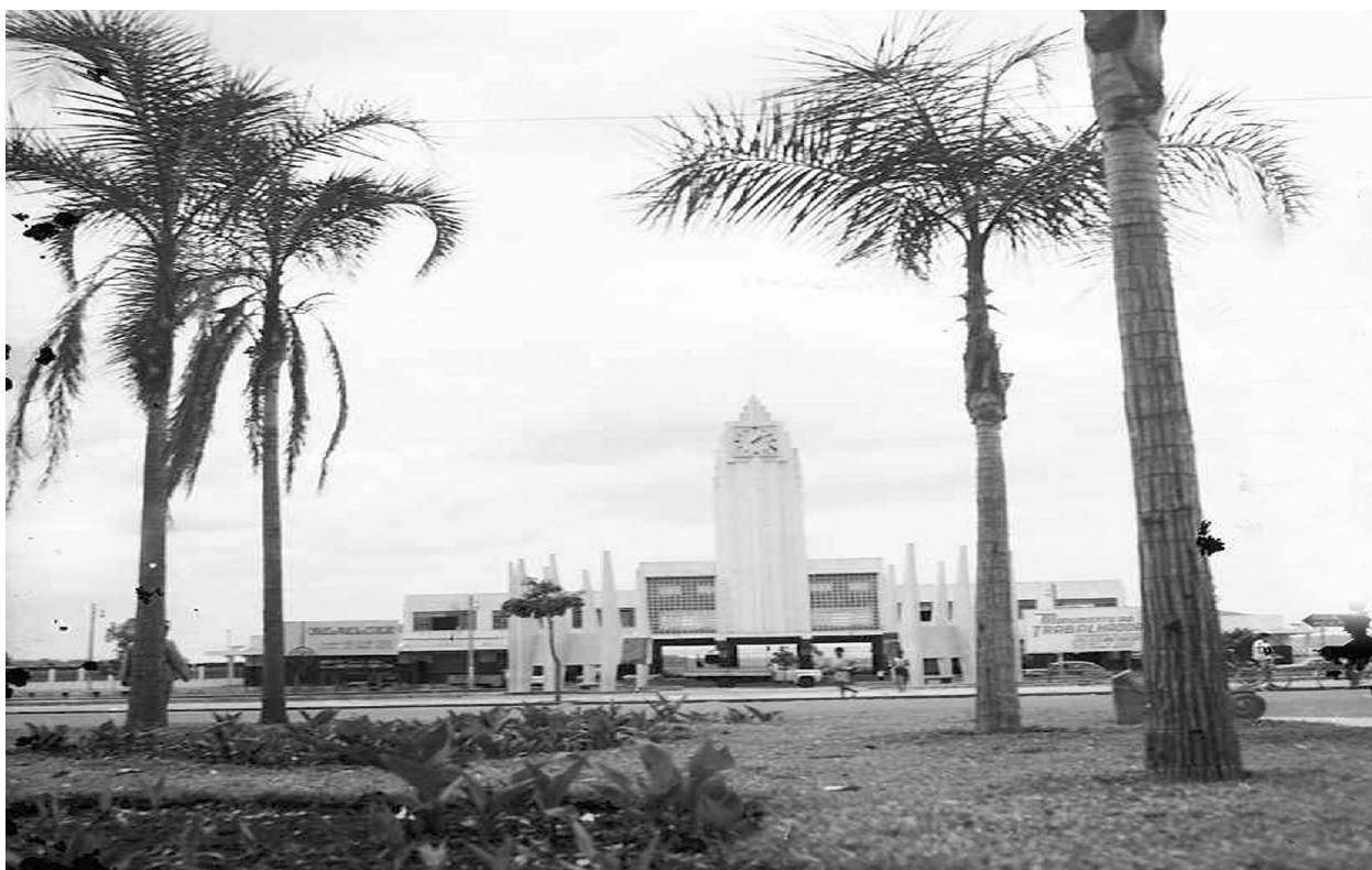
Foto 10 - Vista Frontal da Estação Ferroviária de Goiânia
