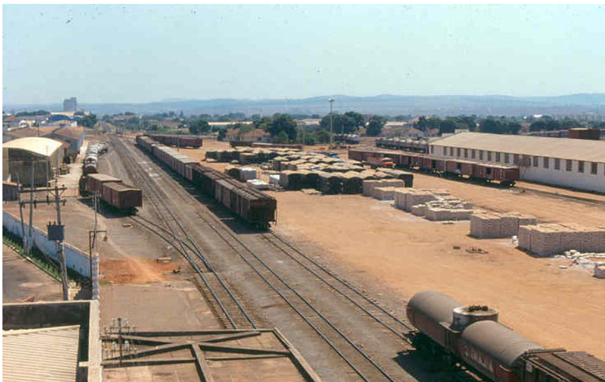
Foto 06 - Galpão de Cargas da Estação Ferroviária de Goiânia
