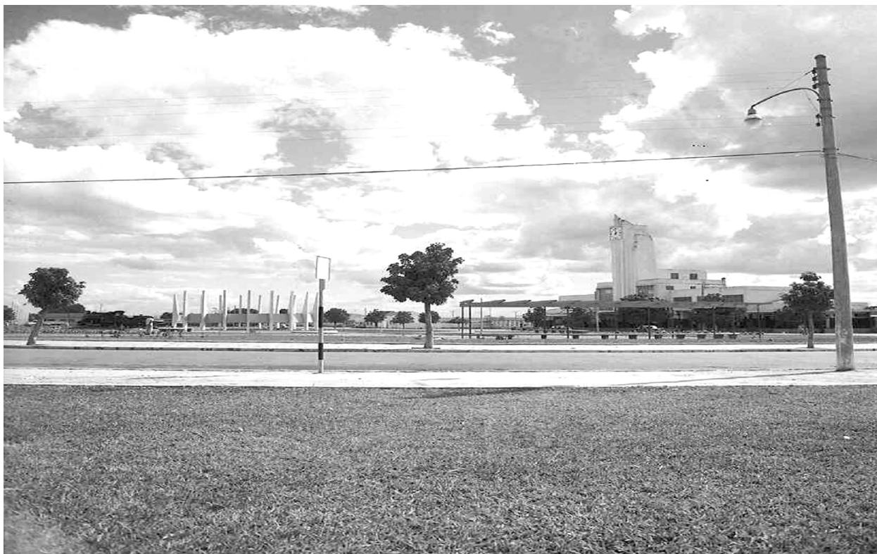
Foto 09 - Vista Lateral da Estação Ferroviária de Goiânia e Monumento ao Trabalhador
