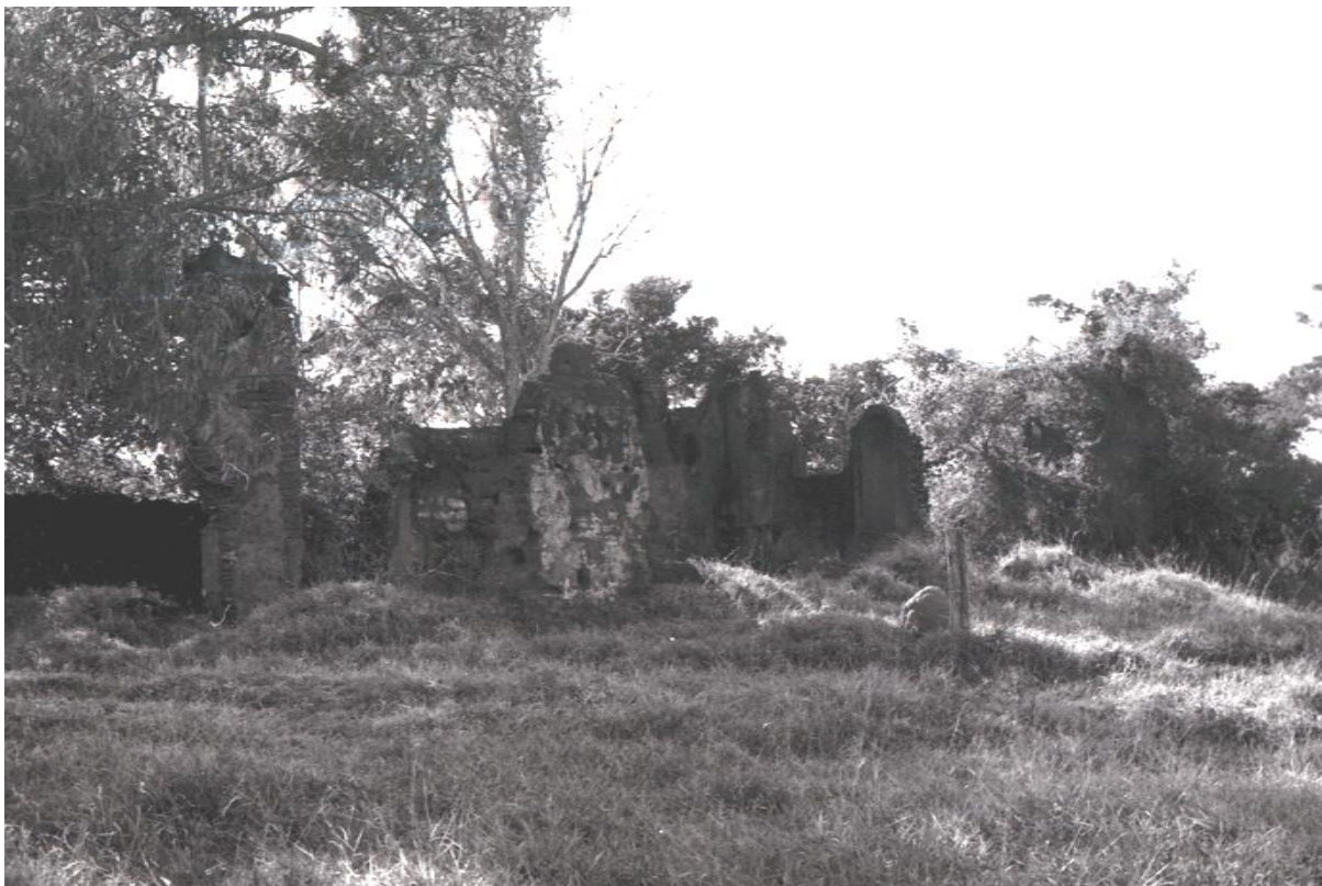
Foto 80 - Fachada Frontal de Igreja de Nª Sª do Pilar de Ouro Fino (ruínas) - 1994 - foto da autora.
