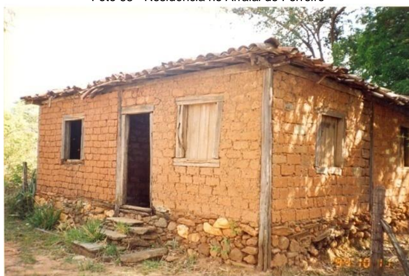
A mesma residência – Notar a construção feita em Adobe com estrutura de madeira e alicerces em pedra. Portas e janelas feitas em madeira. Edificação elevada do nível do solo. 1994. Foto da autora
