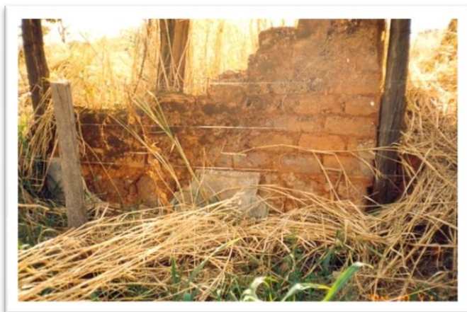
Foto 33 – Restos de Paredes ou muro 1994 – foto da autora.
