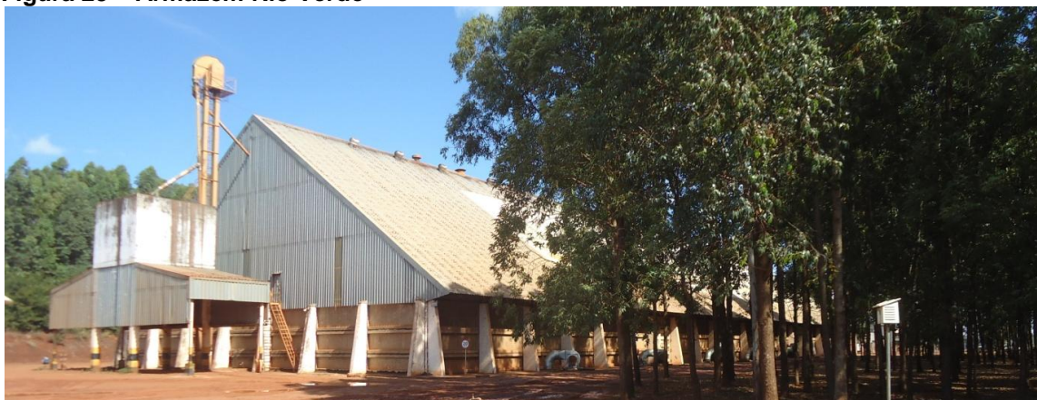
Figura 23 – Armazém Rio Verde
