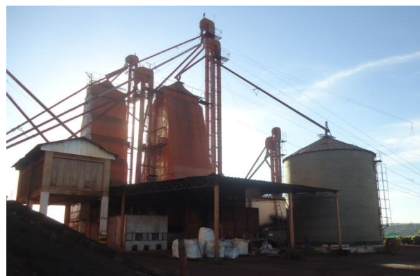
Figura 21 - Secadores, elevadores e Silo – Santa Helena
