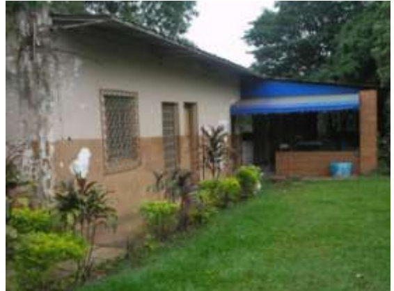
Figura 32: Sede desativada do Automóvel Clube. Fonte: AMMA, 2006.
