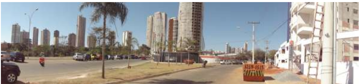
Figura 51: As obras continuam no entorno do Parque Flamboyant, 06/09/2009.
