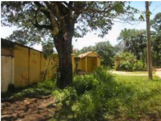
Figura 29: Muro de fechamento do Automóvel Clube que impedia o acesso livre da comunidade ao parque. Fonte: AMMA, 2006.
