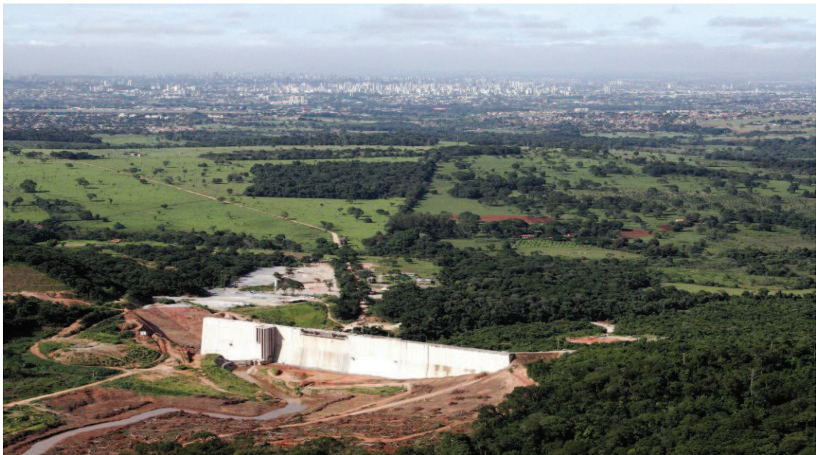
Figura 3 – Construção da Barragem do Ribeirão João Leite
