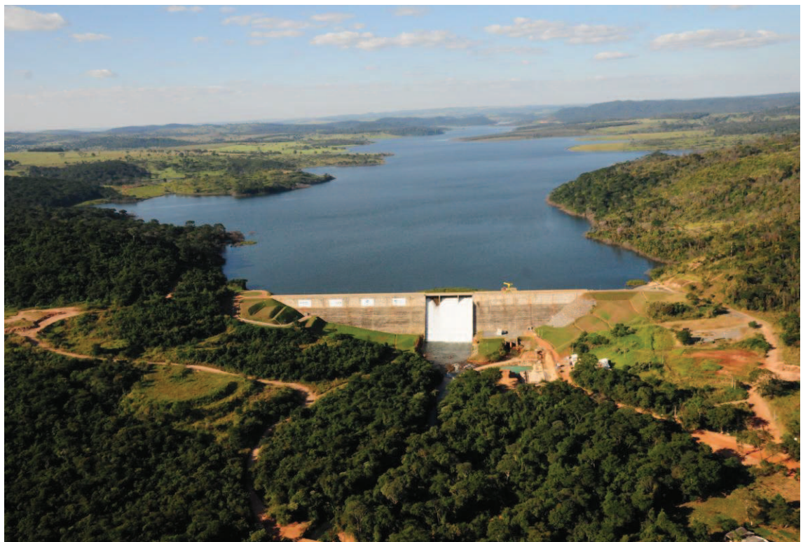
Figura 1 – Foto Aérea da Barragem e Reservatório do Ribeirão João Leite
