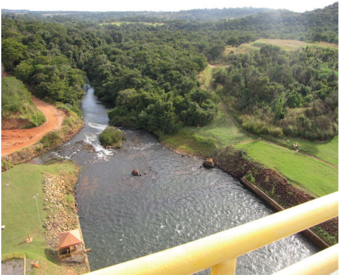
Figura 2 – Vista do Ribeirão João Leite a jusante da barragem
