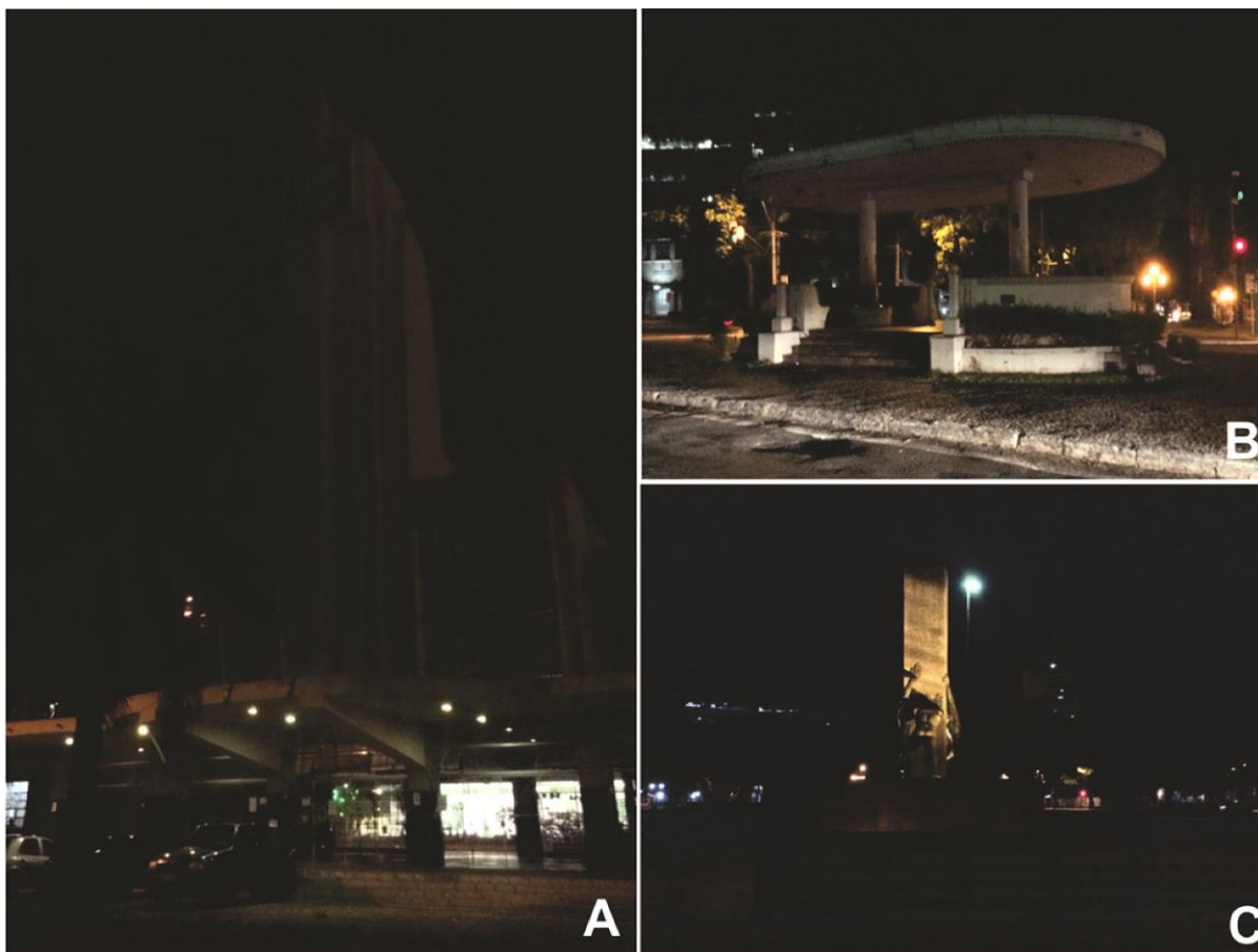
Figura 24: Iluminação de monumentos – Goiânia, Goiás.
