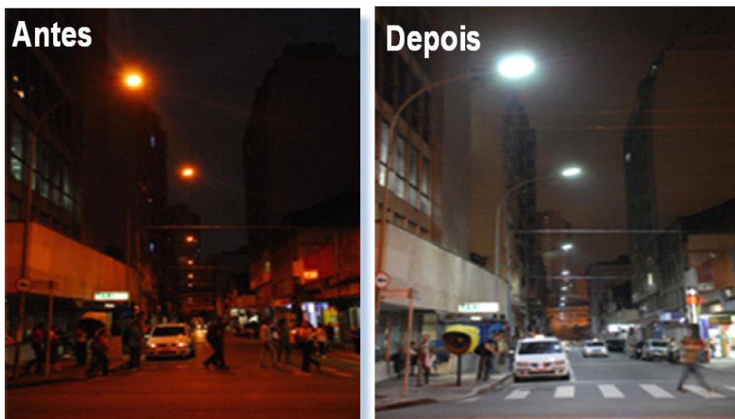
Figura 11: Comparativo antes e depois do uso do LED na iluminação pública (Rua do Arouche, no centro da cidade de São Paulo).
