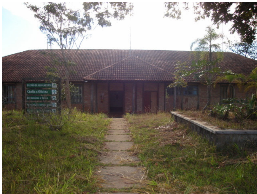
Figura 7 – Vista externa do alojamento.
