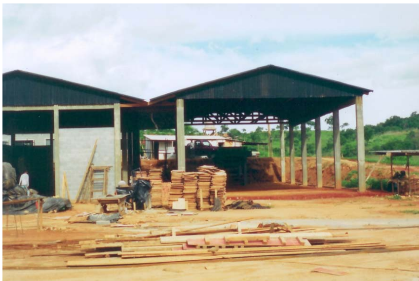
Figura 6. Construção da Usina de Reciclagem Foto do acervo do IDF
