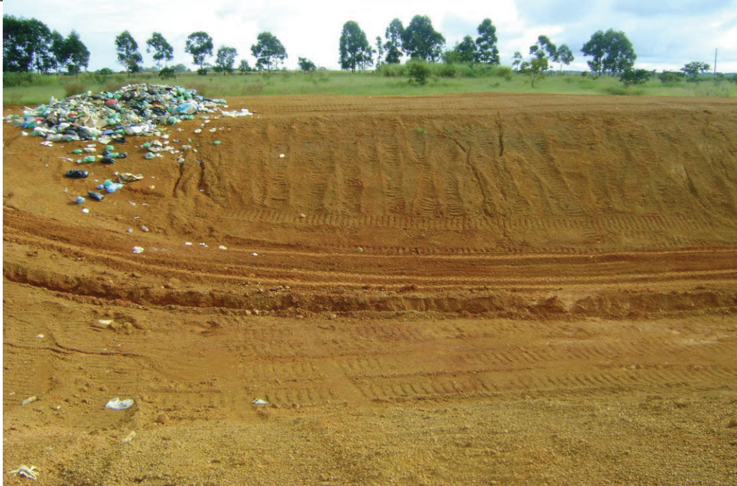
Figura 24 - Construção da primeira vala do aterro sanitário de Vianópolis - 2009. Fonte: Dalton de Sousa, 2009.
