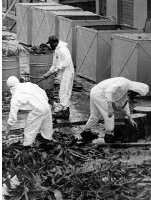
Figura 5: Foto de alguns trabalhadores atuando na remoção de entulhos radioativos. Nem todos usavam as roupas completas e adequadas de proteção, e muitos chegaram a recolher material contaminado com as mãos (sem as luvas apropriadas).
