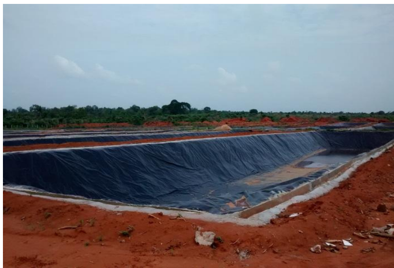
Figura 4 - Obra do aterro controlado/Araguatins.
