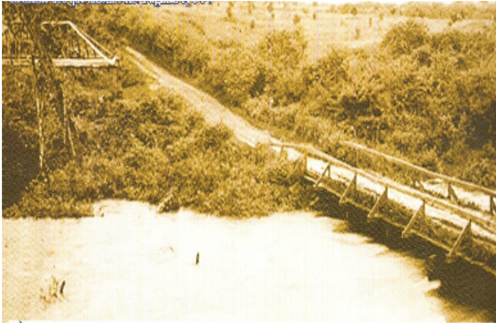
Figura 2.9: Fotografia da ponte de madeira sobre o Rio Meia Ponte na região do Setor Jaó no ano de 1940. Fonte: (MEIA PONTE VIVO, 2009, p. 1)
