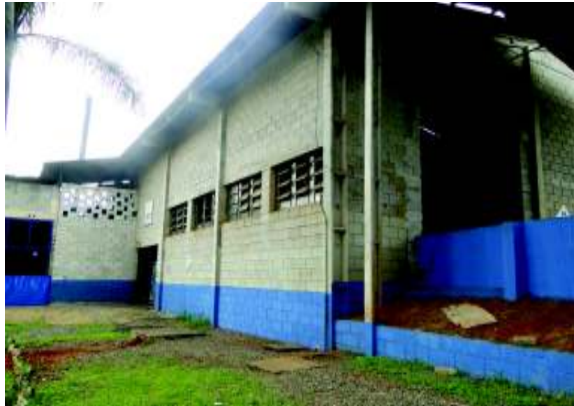
FIGURA 13 - Estação de Tratamento de RSS no Aterro Sanitário de Goiânia
