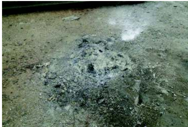
FIGURA 21 - Disposição final inadequada de RSS na Estação de Tratamento dos RSS
