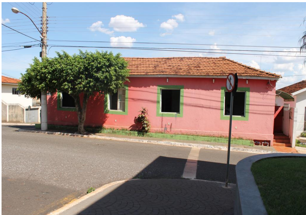
Figura 19. Edificação situada à Praça São Sebastião – Centro Casarão remanescente da cidade no século XIX. Nele está funcionando provisoriamente a biblioteca Pública Municipal enquanto o edifício sede da biblioteca passa por reforma
