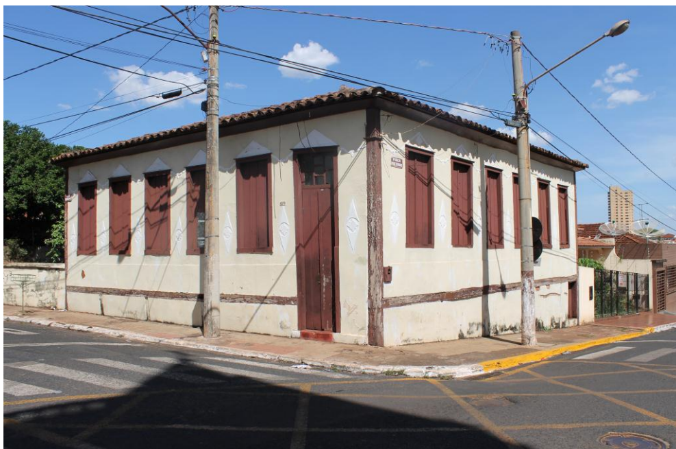
Figura 18. Edificação centenária situada à Praça São Sebastião – Centro
