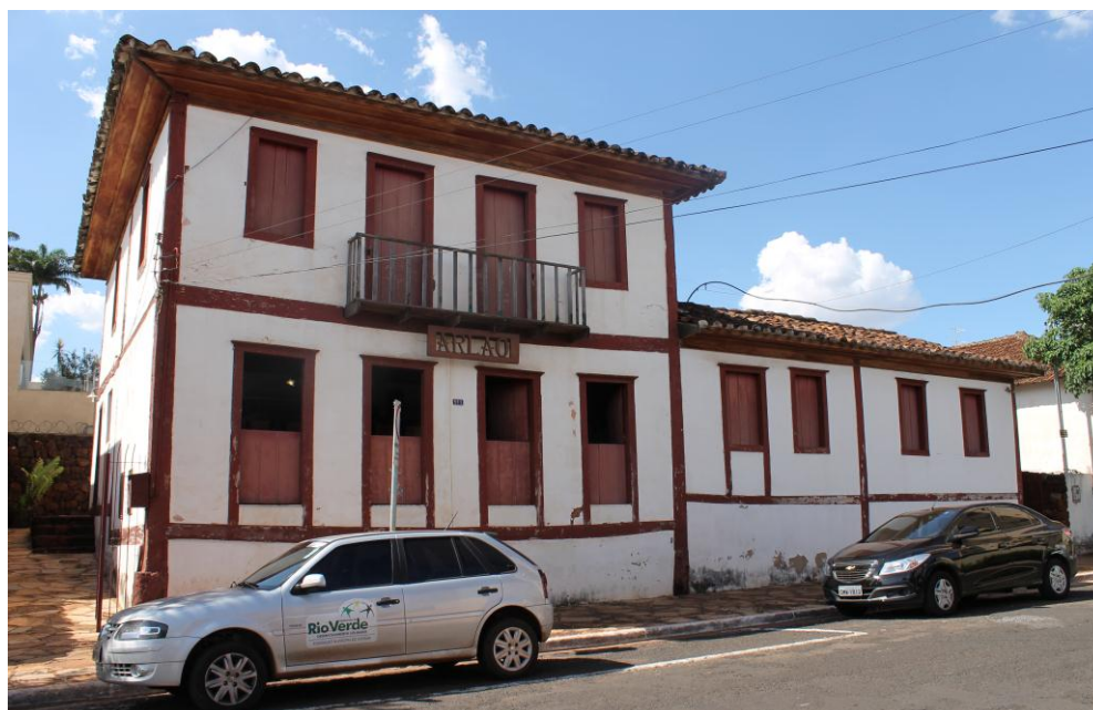
Figura 16- Edifício da Fundação de Cultura e sede da Academia Rio-Verdense de Letras, Artes e Ofícios. Situado à Rua São Sebastião, nº 511 – Centro
