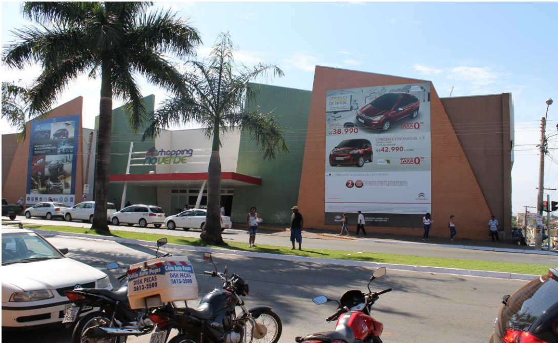
Figura 7. Vista parcial da Av. Pres. Vargas Acesso principal do Shopping Rio Verde
