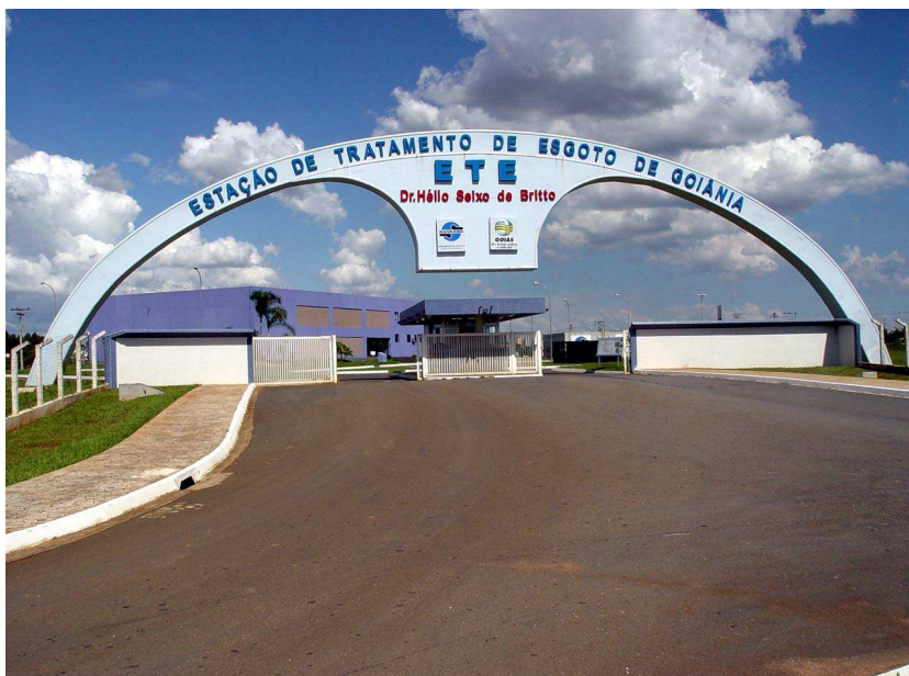
Figura 1. Estação de Tratamento de Esgoto de Goiânia.
