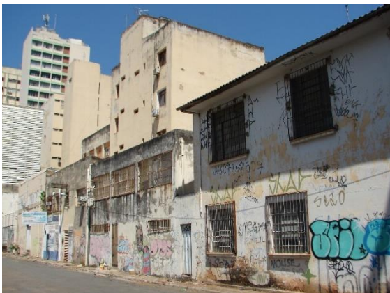
Figura 123. Situação atual beco Quadra 4.
