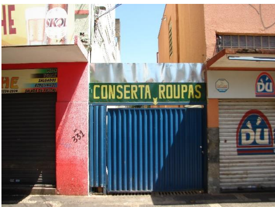
Figura 74. Acesso do beco privatizado.
