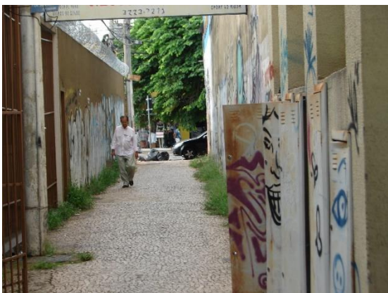
Figura 127. Situação atual beco Quadra 38.
