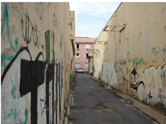
Figura 125. Situação atual beco Quadra 8.
