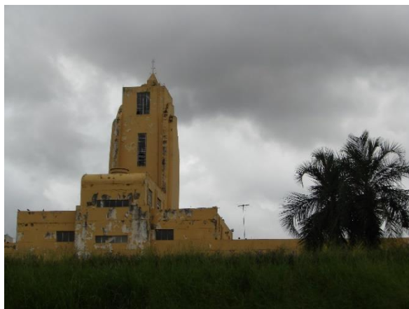
Figura 159. Degradação externa do edifício tombado.
