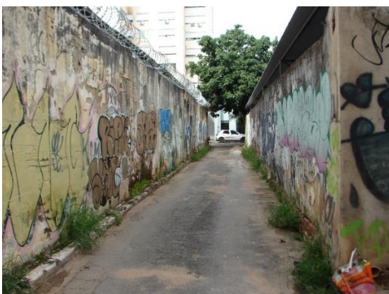
Figura 129. Situação atual beco Quadra 5.
