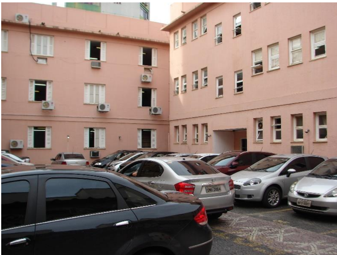
Figura 68. Estacionamento de veículos no beco de acesso ao Grande Hotel.
