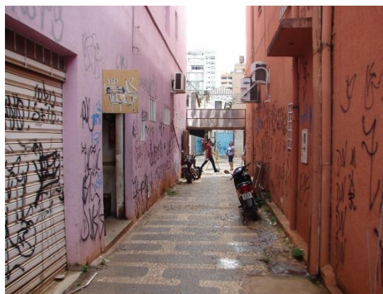
Figura 128. Situação atual beco Quadra 20.
