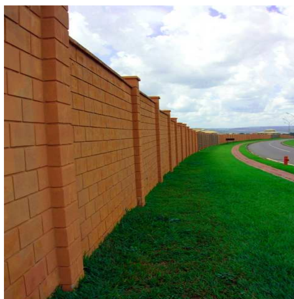
Foto:Ycarim Figura 17- Muro do Residencial Alphaville Flamboyant
