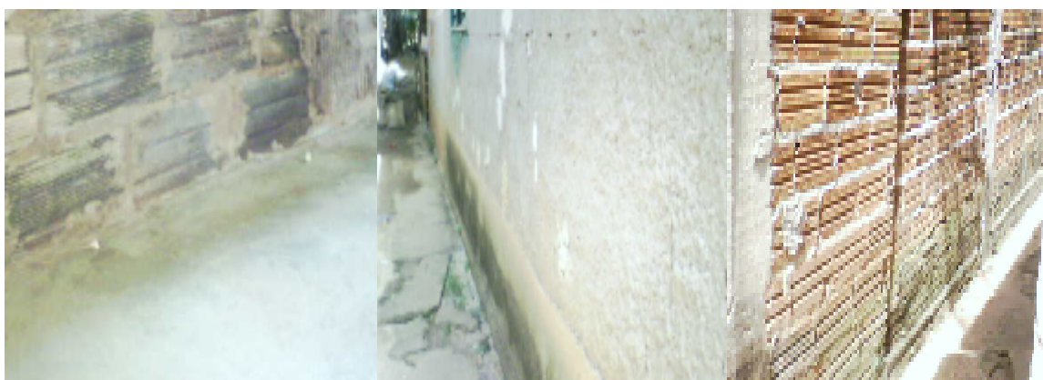
Figura 13. Moradia – Recanto do Bosque – área da planície de inundação do Rio Meia Ponte, margem direita – última quadra. Foto: Celnia Costa e Dinamara T.Versan,2008.
