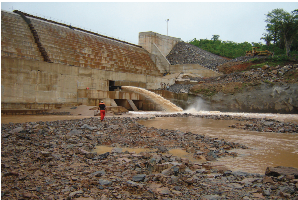
Figura 6. Trecho de vazão reduzida do Rio Caiapó no município de Iporá - GO.
