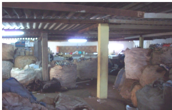
Figura 12 – Cômodo da cooperativa compartilhado por depósito e cozinha (15 jan. 2010)
