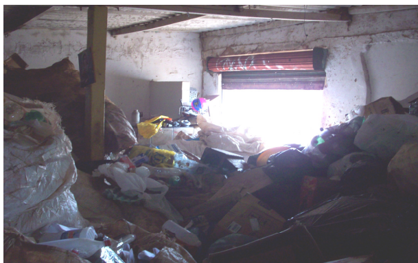
Figura 11 – Catadores cooperados expostos ao local abafado e pouco ventilado (15 jan. 2010)
