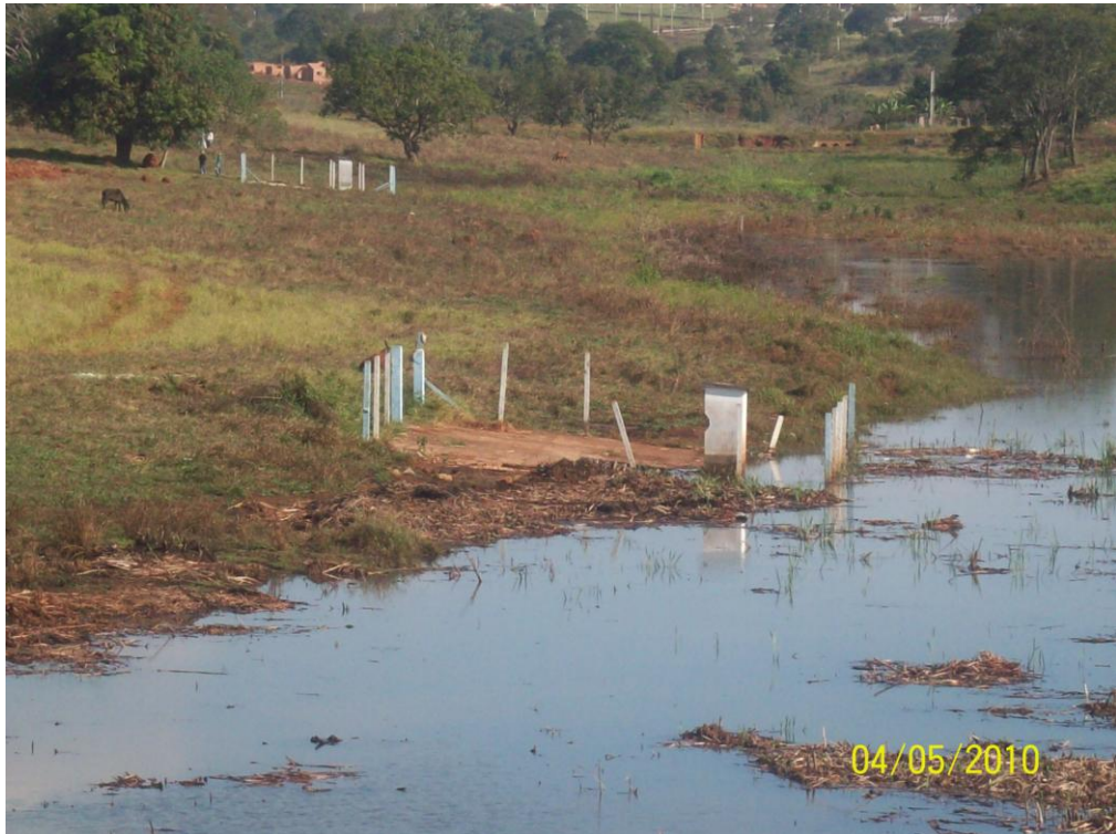
Figura 27: Dois poços de bombeamento de água subterrânea.
