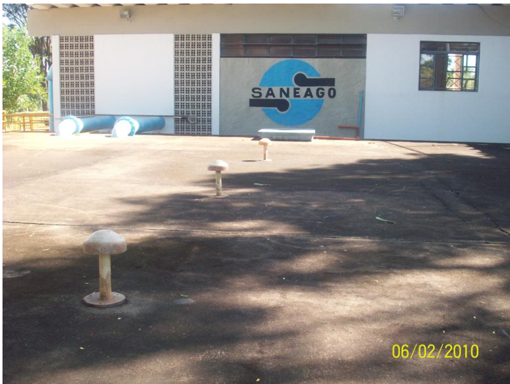
Figura 8: Reservatório de contato.
