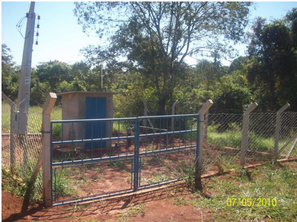
Figura 28: Um dos onze poços que abastecem a caixa de reunião.
