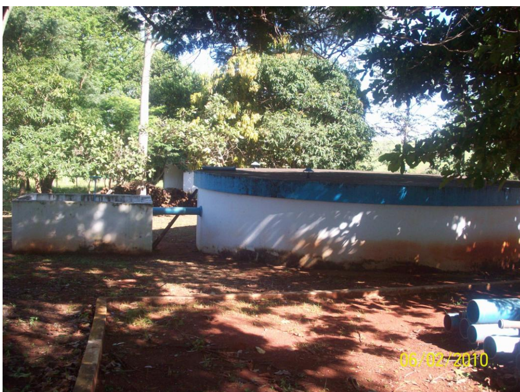
Figura 9: Reservatório de Água tratada (capacidade para 200.000 L).
