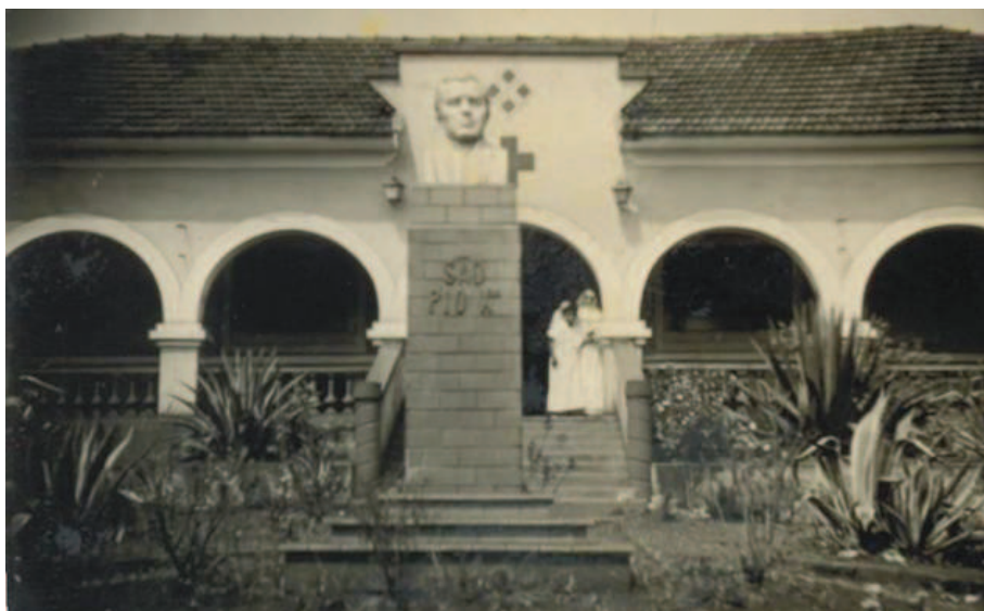
Imagem 5: Hospital São Pio X. Fonte: Biblioteca Municipal de Ceres.
