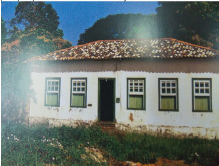
Figura 4 – Construção rural no município da cidade de Goiás em taipa de pilão, esquadrias de madeira e caiação
