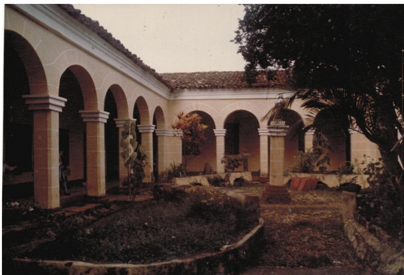
Figura 13– Vista interna atual do primeiro prédio do Colégio das Irmãs Dominicanas 101
