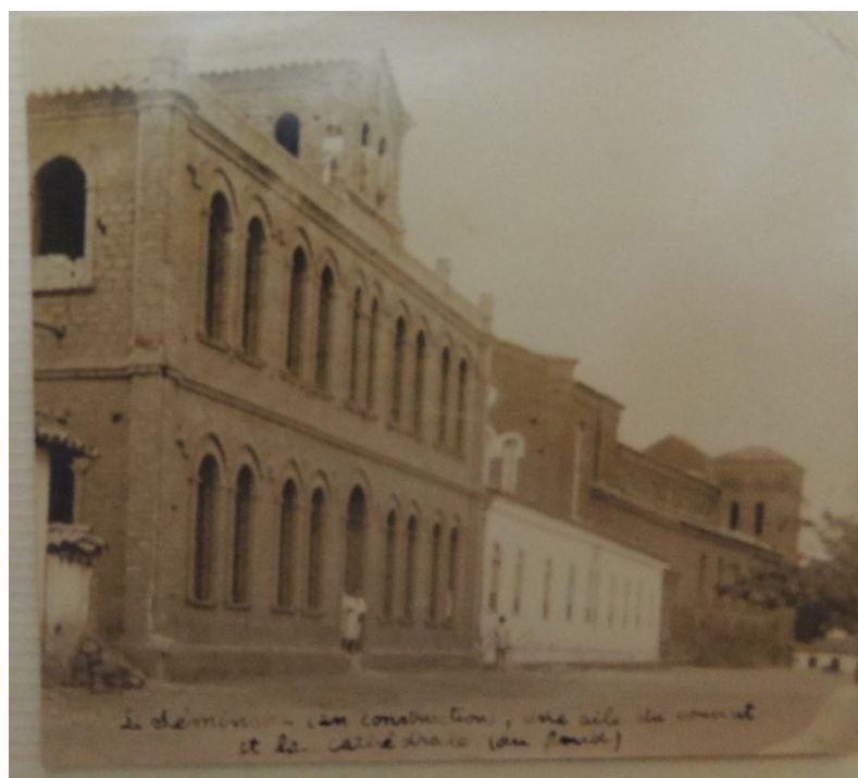
Figura 19 – Prédio do Seminário São José/Palácio Episcopal/Cúria Diocesana em fase de acabamento
