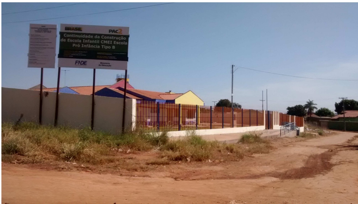
Foto 09 – CMEI em construção no Setor Buriti Sereno Fonte: acervo pessoal (foto tirada em maio de 2016)
