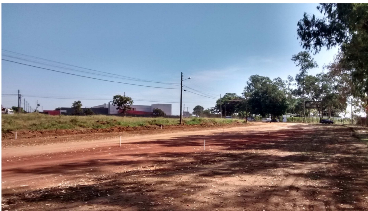
Foto 12 – ITEGO em construção no Setor Buriti Sereno 3ª etapa Fonte: acervo pessoal (foto tirada em maio de 2016)
