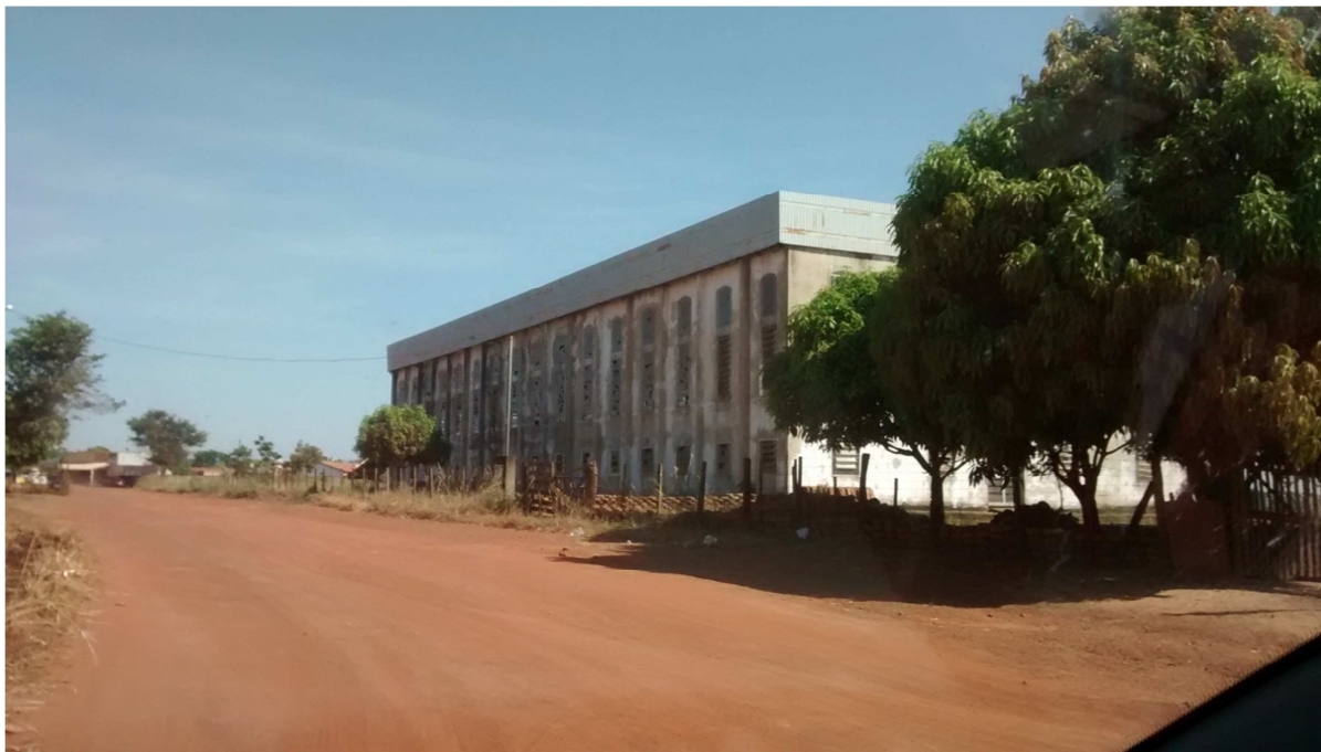
Foto 11 – Igreja em construção no Setor Buriti Sereno 3ª etapa Fonte: acervo pessoal (foto tirada em maio de 2016)
