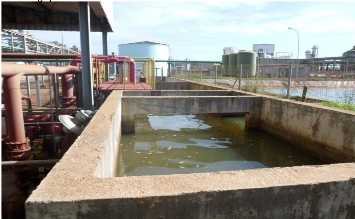
Figura 8. Lagoa de equalização para neutralização do pH da água para reutilização na fertirrigação.
