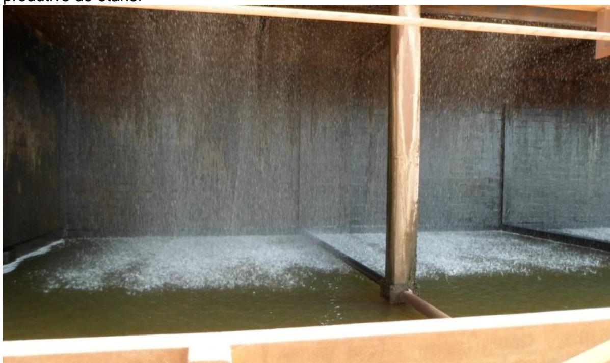
Figura 10. Resfriamento da água utilizada na indústria para reutilização no processo produtivo do etanol
