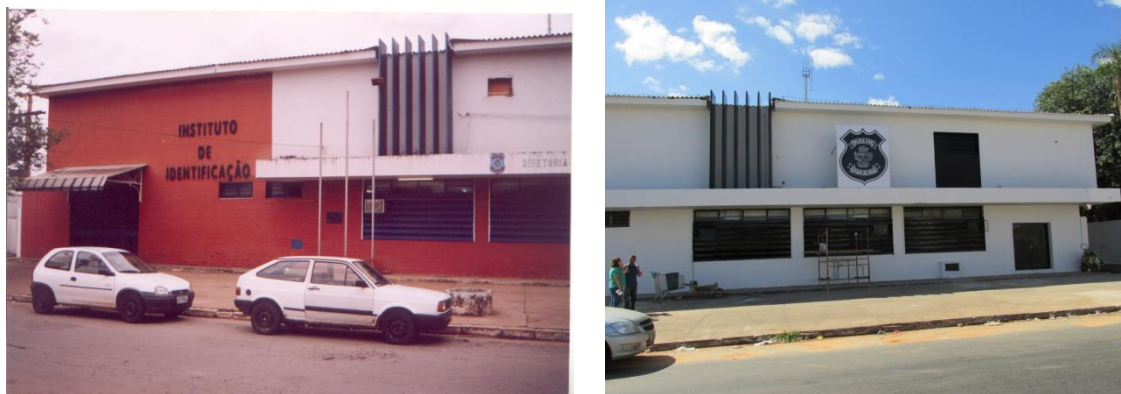
(Fig.24: Frente do prédio do Instituto de Identificação: à esq. até início de 2015 e à dir. a partir de 2015. Fonte: ARQUIVOS/II-GO)
