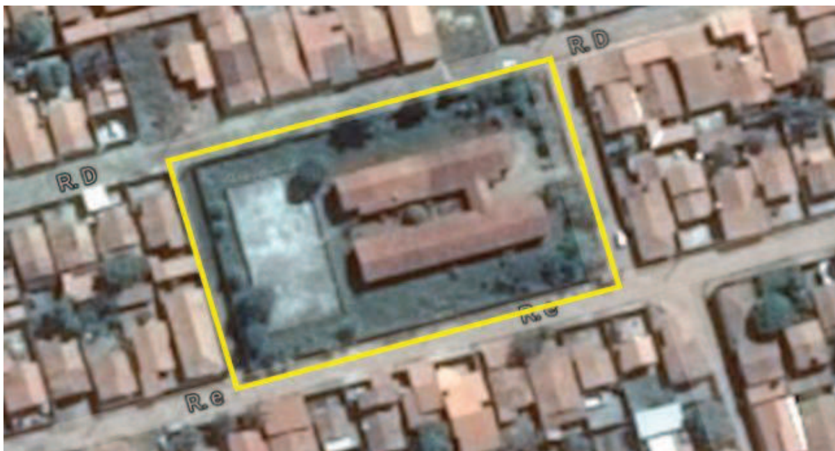
Figura 10 - Imagem aérea da escola 20
