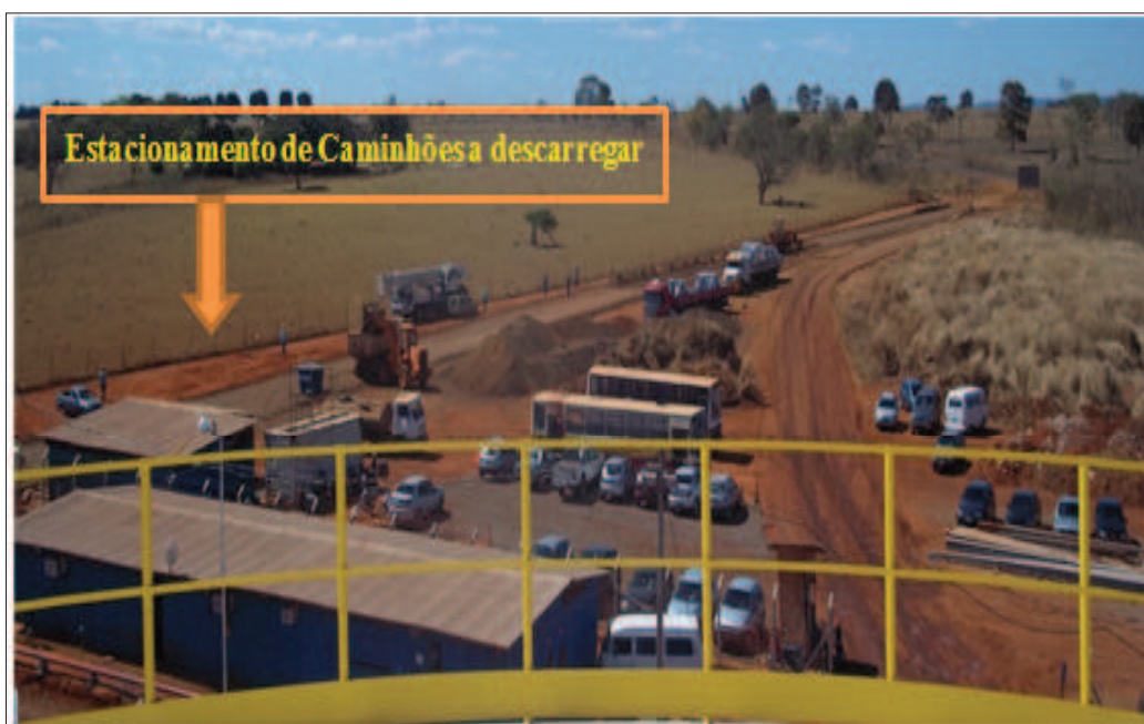
Figura 18 – Área de estacionamento da obra.
