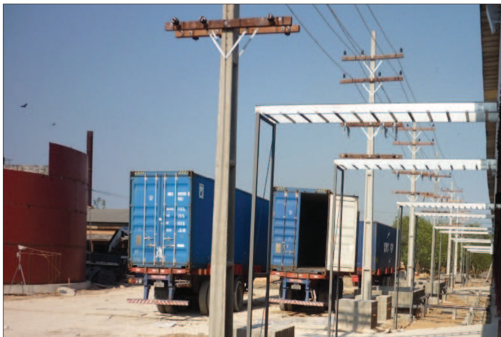
Figura 7 - Carretas sendo descarregadas na obra.
