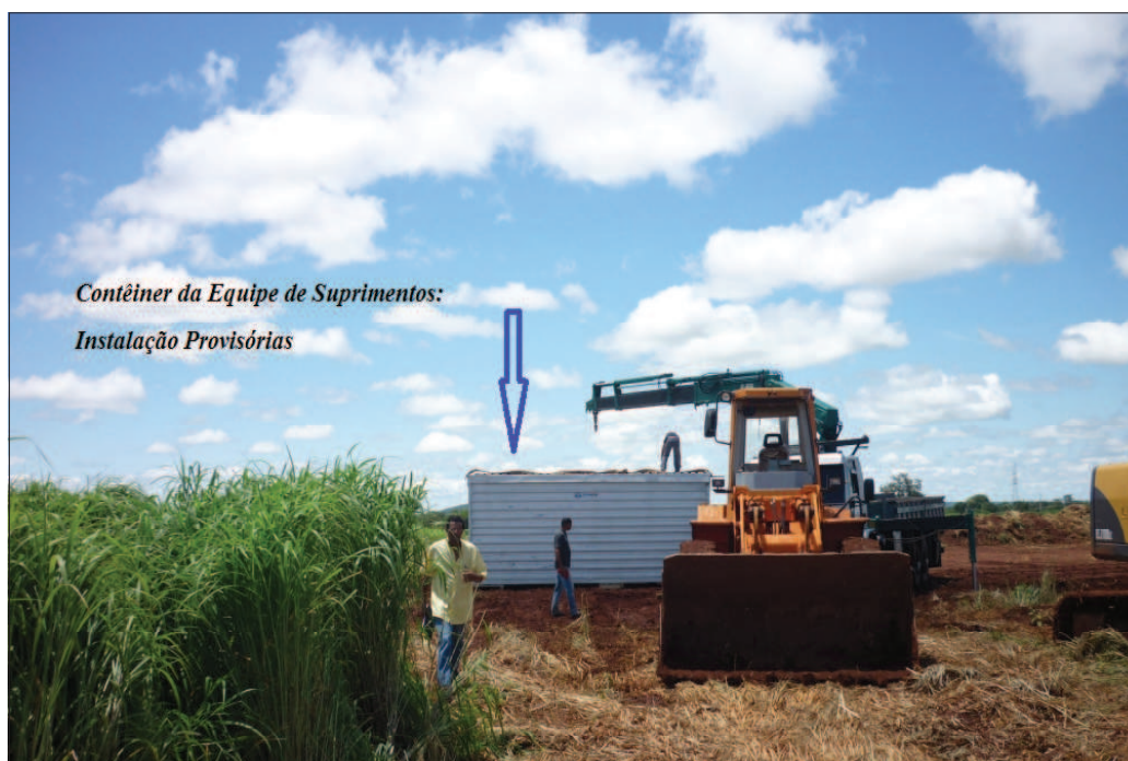
Figura 15 - Chegada das instalações provisórias da Equipe de suprimentos na Obra. Fonte: Arquivo de documentação da Tecmon / obra Palmeiras, 2011.
