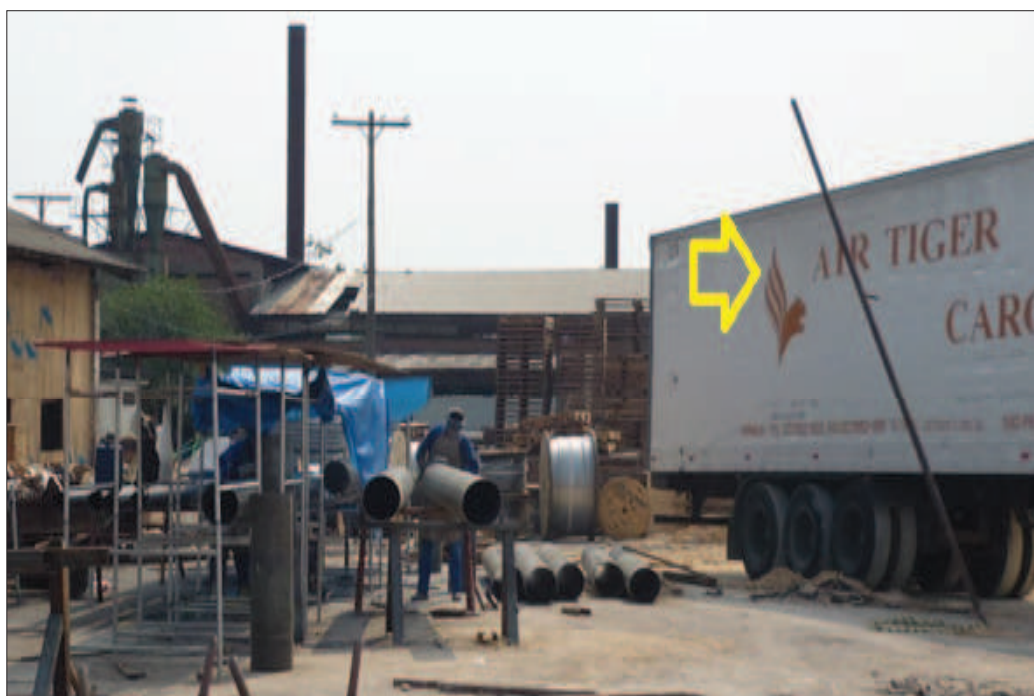
Figura 8 - Carretas do transportador aéreo sendo descarregada na obra.
