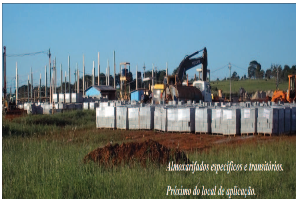
Figura 19 – Almoxarifados específicos e transitórios da obra. (Blocos de Concreto). Fonte: Arquivo de documentação da Tecmon / obra Palmeiras, 2011.
