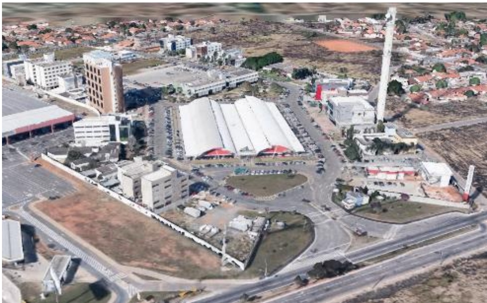
Figura 4: Vista área do Condomínio Empresarial em Aparecida de Goiânia/GO.
