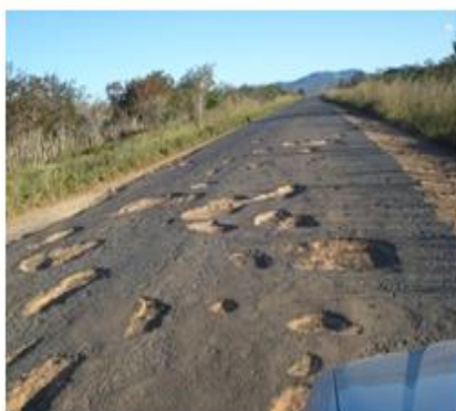
Figura 11 - BR 158 falta de acostamento Rib. Cascalheira e muitos buracos
