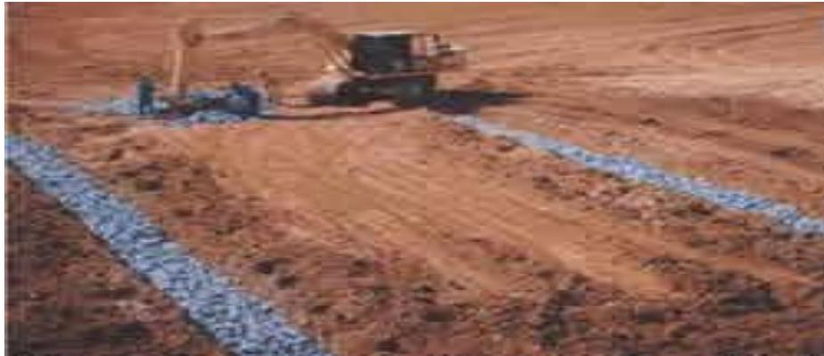
Figura 4a Preparação e limpeza do terreno para implementação do aterro sanitário
