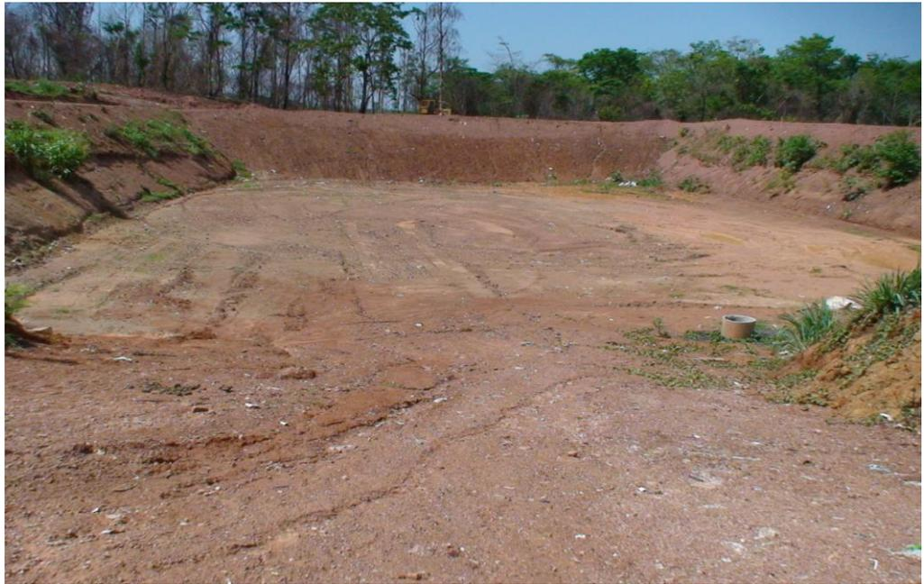
Figura 17. Vista frontal da vala do aterro sanitário aguardando a geo-membrana
