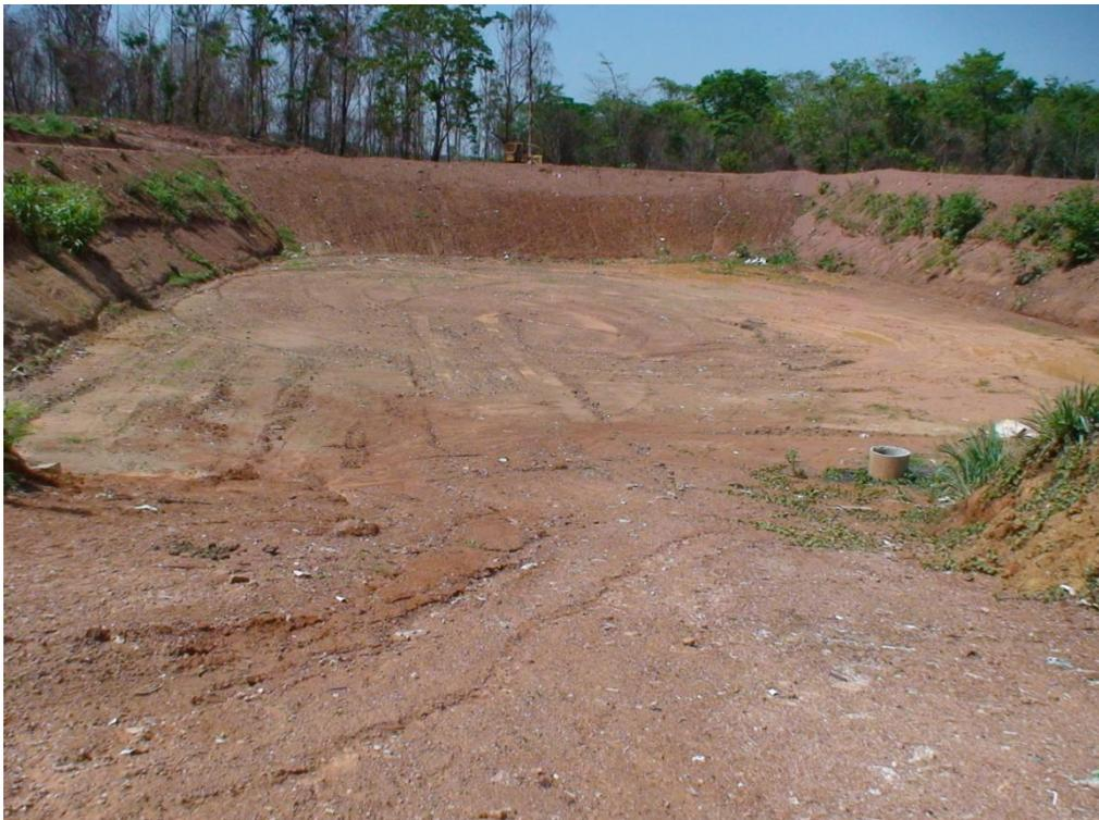
Figura 11a. Vala do aterro sanitário aguardando camada geo-membrana
