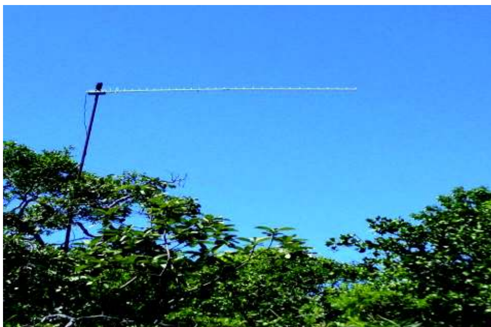
Figura 3 – Torre de celular próximo à Escola Kalunga II do Vão de Almas
