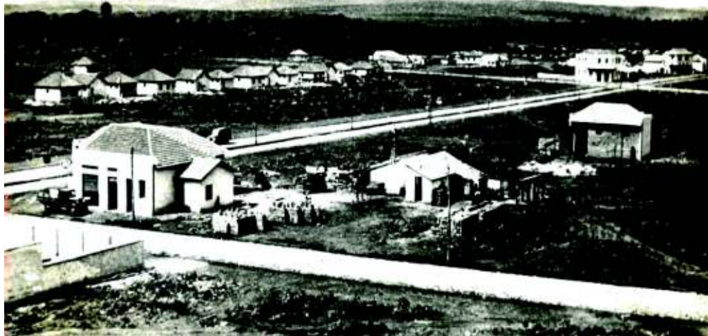
FIGURA 3. Construção das primeiras casas e dos primeiros conjuntos residenciais, 1934, Goiânia. Fonte: Acervo Biblioteca SEPLANH.
